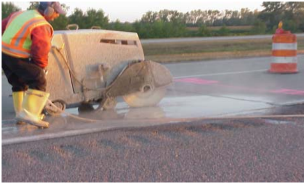
a) Sawcutting the existing slab.
