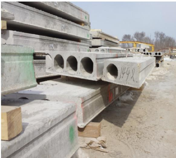
Apilamiento desnivelado; soporte de madera no alineado (Foto)
