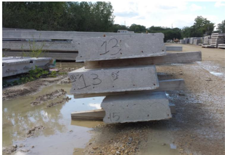
Apilado desalineado, apilado inclinado y suelo blando (Foto)
