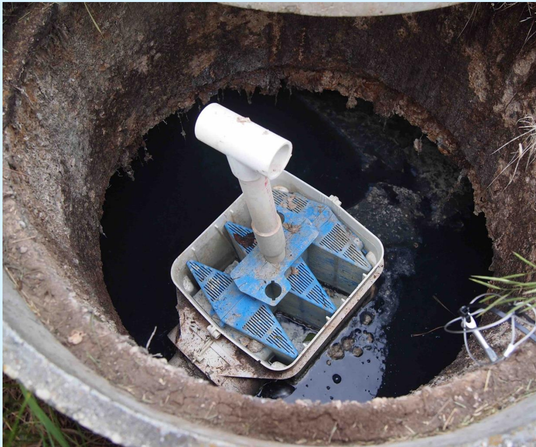
Effluent filters
